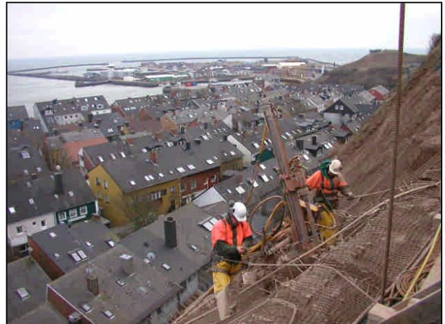
Figura 10. Fasi di perforazione su slitte sospese
