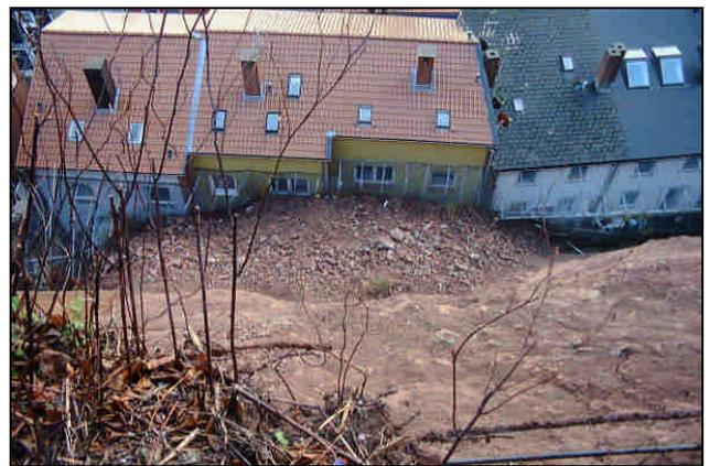
Figura 7. La massa di materiale franato in forma sostanzialmente piano-parallela lungo la superficie superiore del substrato stabile ha danneggiato alcune abitazioni a Helgoland (Germania).
