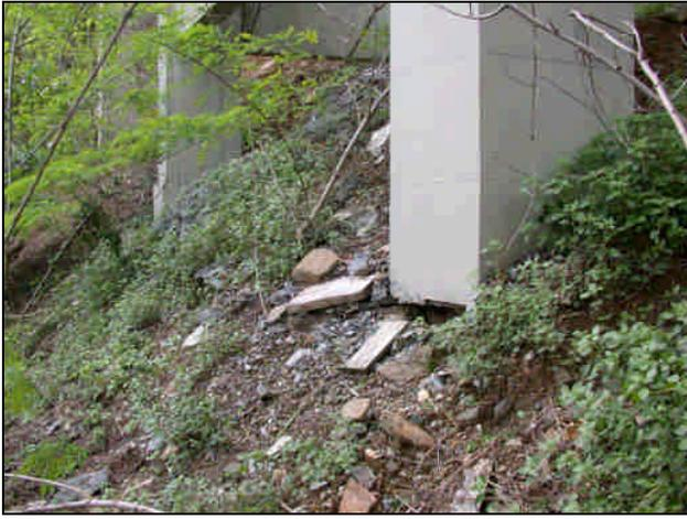
Figura 14. Dettaglio di una pila del Viadotto Teccio interessata da scaldamento alla base
