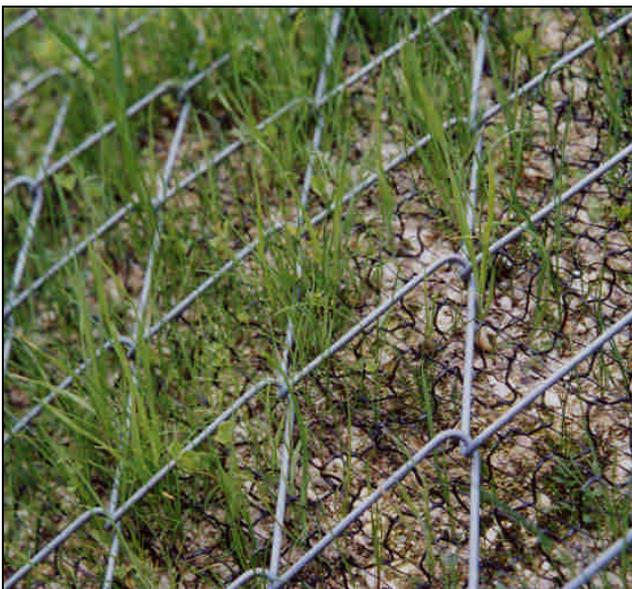
Figura 1. La rete ad alta resistenza, in questo caso accoppiata a geostuoie sintetica anti-erosione.
