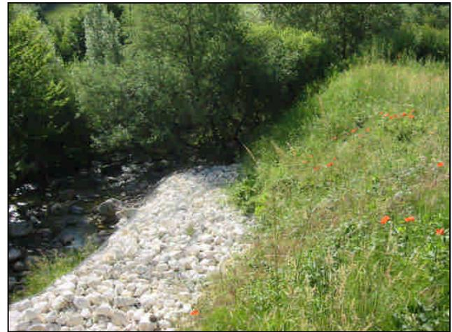
Figura 13. L'intervento di messa in sicurezza della sponda sinistra del Torrente Aventino. E' visibile dopo alcuni mesi lo sviluppo vegetazionale al di sopra dello zoccolo in pietra.
