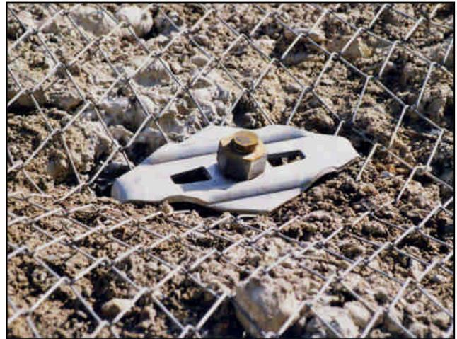
Figura 2. La speciale piastra cuspidata di ripartizione dei carichi dell'ancoraggio, fermamente pressata sul terreno.
