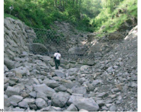
9. Alcune fasi della messa in opera del sistema di mitigazione degli effetti di trasporto in massa producibili, contestuale al sistema di osservazione strumentale lungo il T. Grametto
