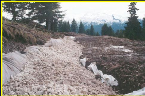
Il progettista deve calcolare qual è la quantità d'acqua da smaltire e qual è portata idraulica della trincea, in funzione del bacino imbrifero, della permeabilità dei terreni e delle pendenze esistenti
