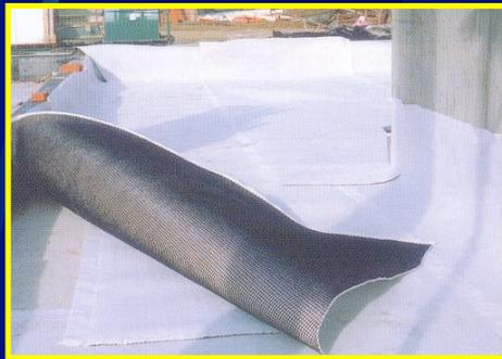
▪ I **GEOCOMPOSITI DRENANTI** svolgono solitamente la funzione di drenaggio e filtrazione; i prodotti adatti allo scopo sono il RECYTOP, il PAVIGRID, il PAVIDRAIN. Si differenziano per valori di trasmissività idraulica, spessore e comprimibilità.
