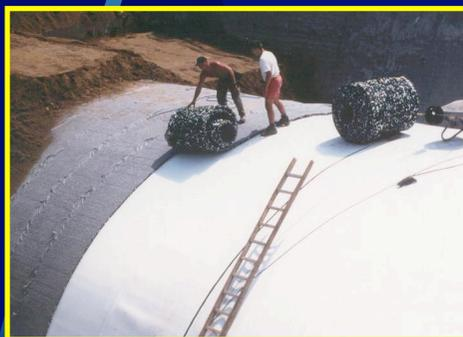
In presenza di venute d'acqua diventano importanti anche le funzioni di **filtrazione** e di **drenaggio**.
