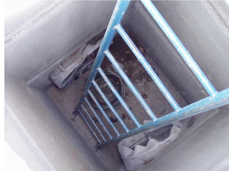
avendo l'accortezza di tirare all'interno del pozzetto la geomembrana in polietilene posta inferiormente all'elemento drenante
