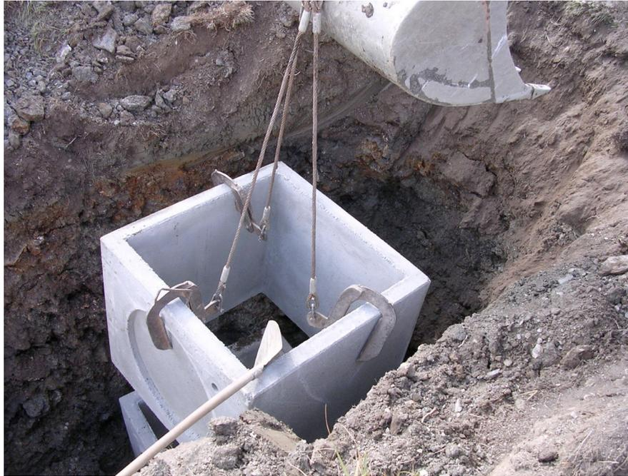
In corrispondenza dei principali cambi di pendenza e dei collegamenti con le tubazioni di scarico sono stati utilizzati pozzetti modulari ispezionabili con sezioni interna di cm 100 x 100, ed altezza massima pari a 3.5 m che vengono calati all'interno della trincea mediante l'escavatore cingolato
