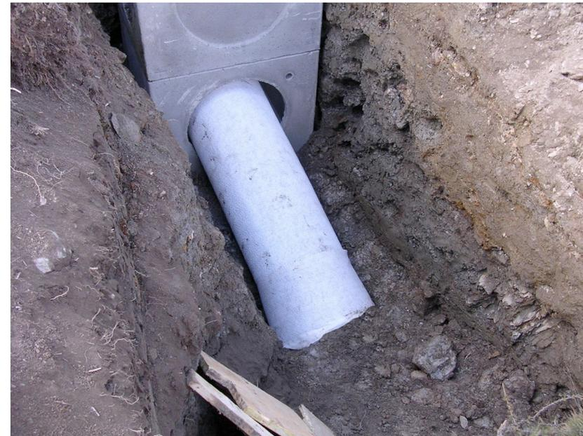
L'elemento drenante viene inserito nel pozzetto forando l'apposito pannello circolare non armato presente sulla faccia del pozzetto...
