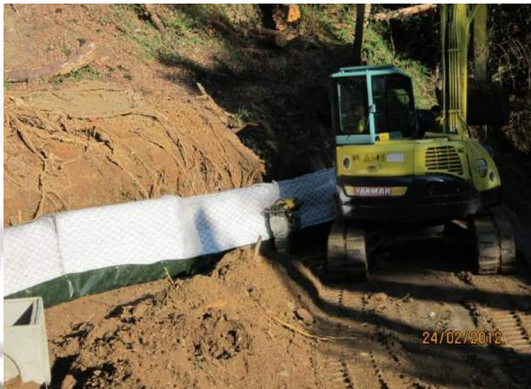
Posa trincea drenante Gabbiodren a monte del rilevato terra rinforzata + Gabbioni
