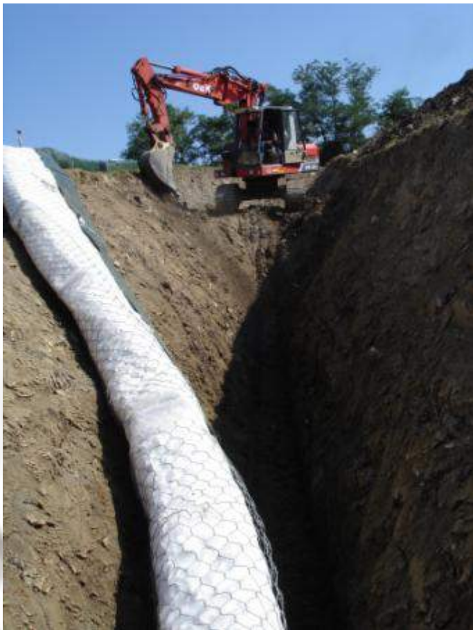
TRINCEA GABBIODREN SEZIONE DRENANTE DEL MANUFATTO 0,30 MQ
