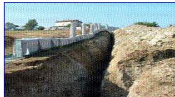
esempio di posa di trincea con camini
