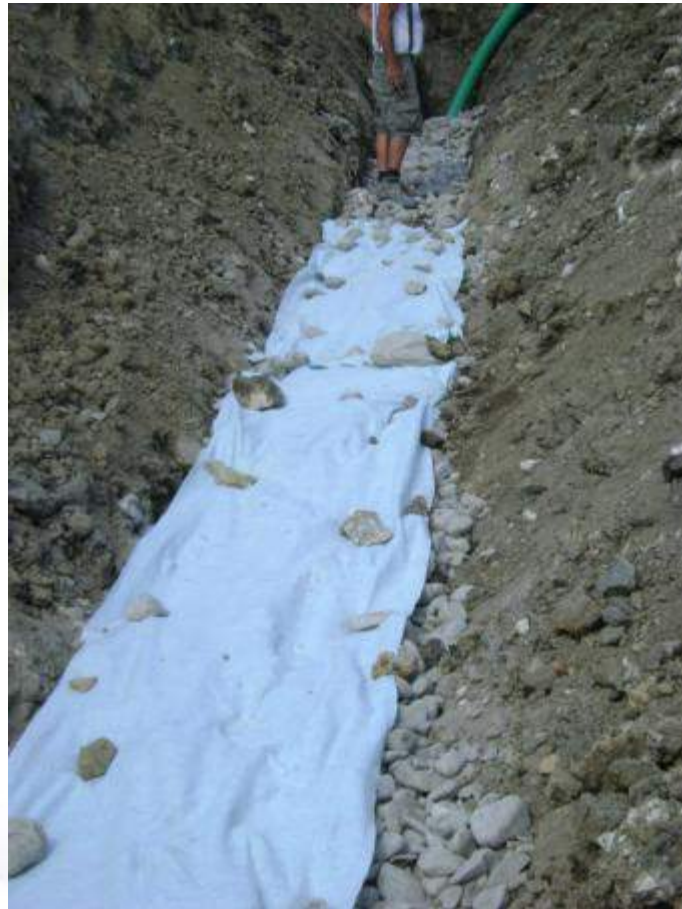
TRINCEA TRADIZIONALE SEZIONE DRENANTE DEL MANUFATTO 0,95 MQ
